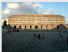
Fig. 1 - Il palazzo Reale. Sede della Biblioteca
